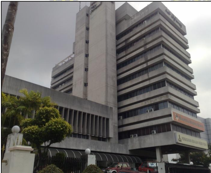
BANGUNAN WISMA WAN MOHAMAD
